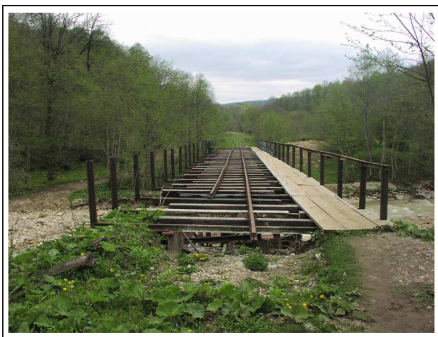
Восстановленный мост в Мезмае
